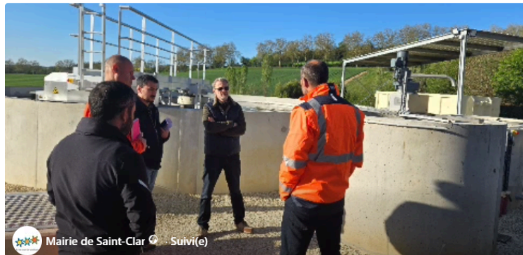
Nouvelle station d'épuration de Saint-Clar
