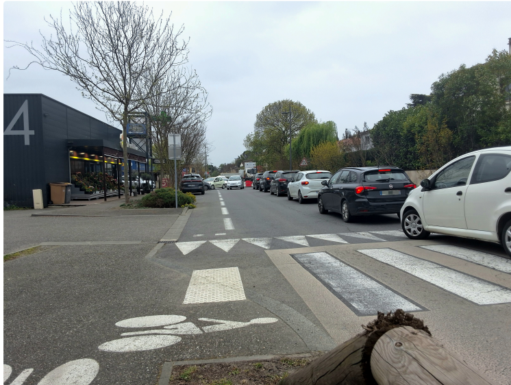
INFO TRAVAUX : Circulation alternée Rue du 8 Mai à Auch.
