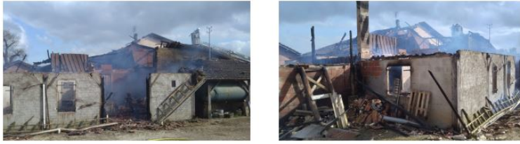
Deux bâtiments détruits par un incendie
