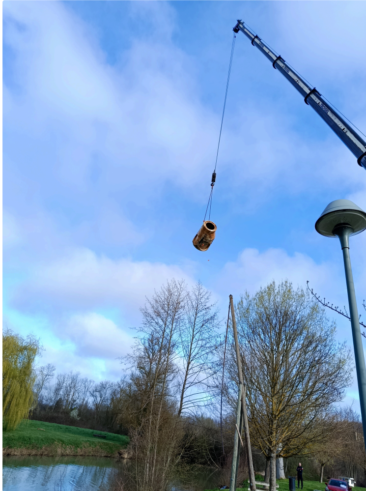
Opération de haut vol à Pavie : Le Vieux Pont retrouve sa sécurité
