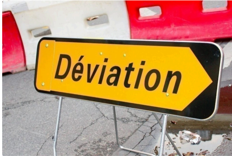
Fermeture de la RD1021 pour travaux – 12 mars 2026
