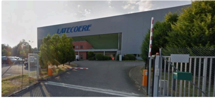
Suite à une fuite de gaz à Latécoère, une centaine de personnes évacuées
