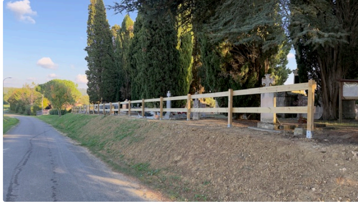
Travaux d'aménagement au cimetière
