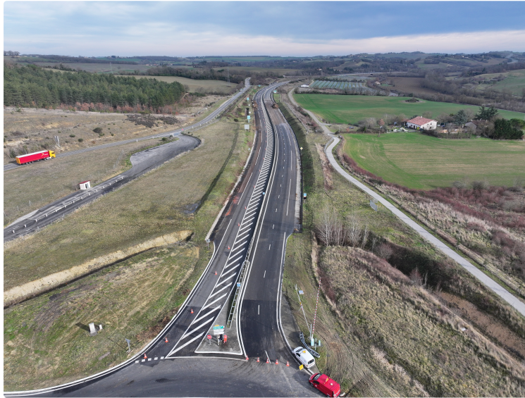
Manifestations agricoles : réouverture de la RD1124 entre Auch et Aubiet
