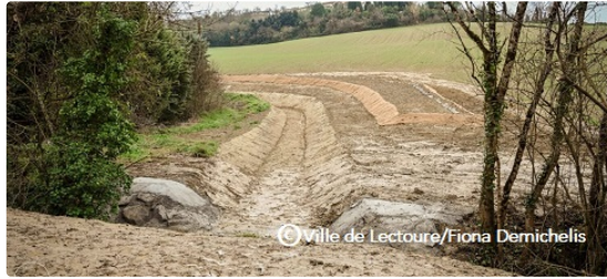
Le chantier du bras de décharge du Foissin est terminé
