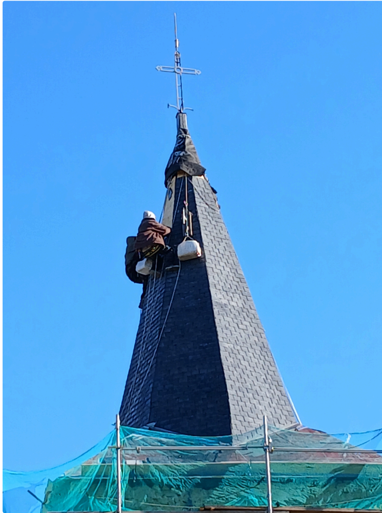
Charpentiers cordistes, ils défient la météo
