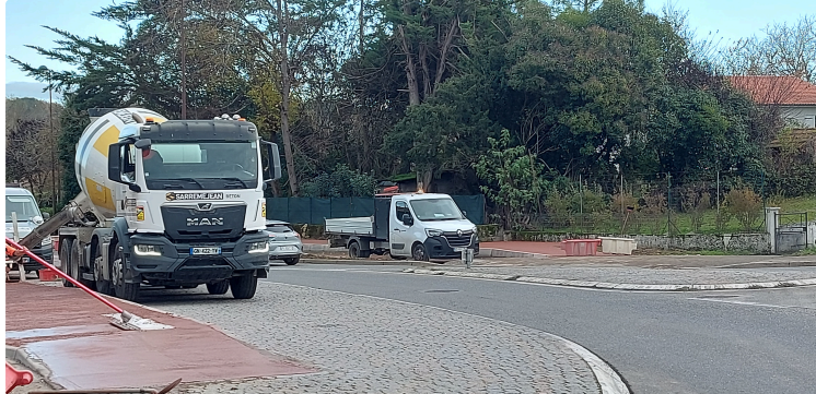
Arrêts de bus et route royale : retards dans les travaux
