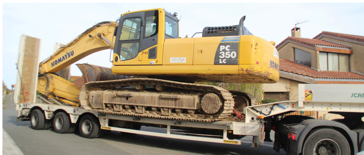
Mise aux normes du réseau d'assainissement
