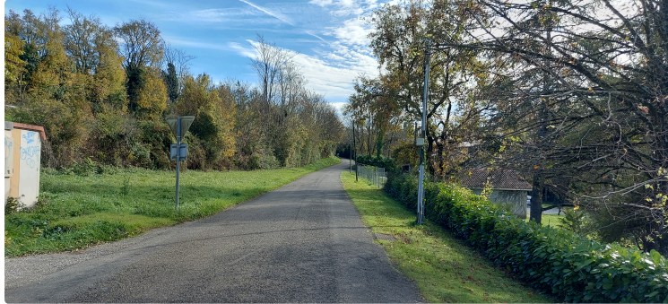
Travaux de sécurisation de l'ancienne route royale
