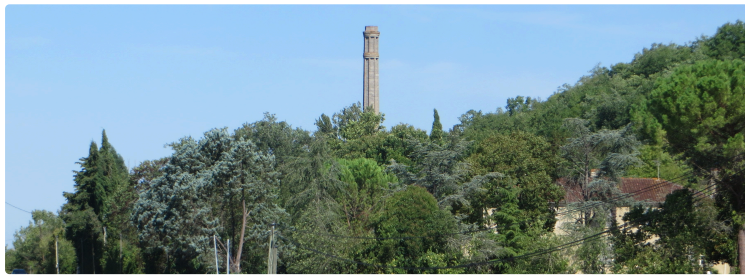
L'usine du Pontic à Barran
