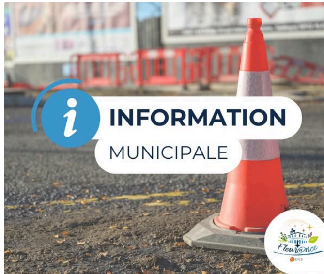
Travaux de l'avenue Martial Cazes
