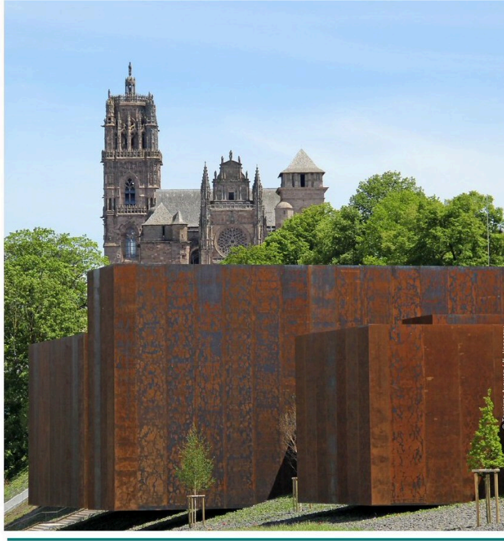
Exposition sur des bâtiments récemment construits
