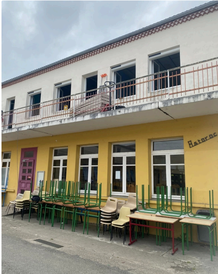
Gros travaux d'envergure durant les vacances
