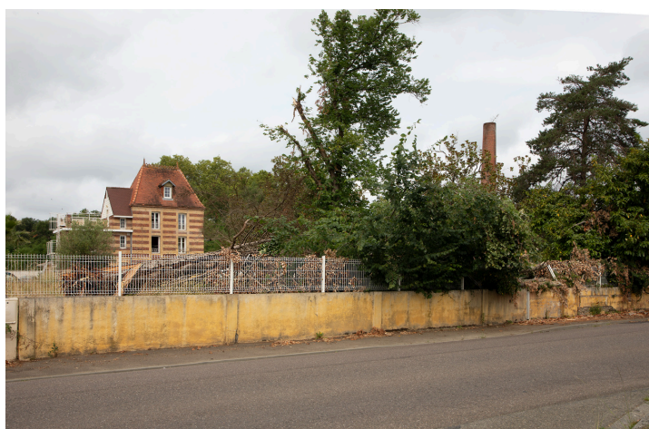
Dégâts avenue des Pyrénées
