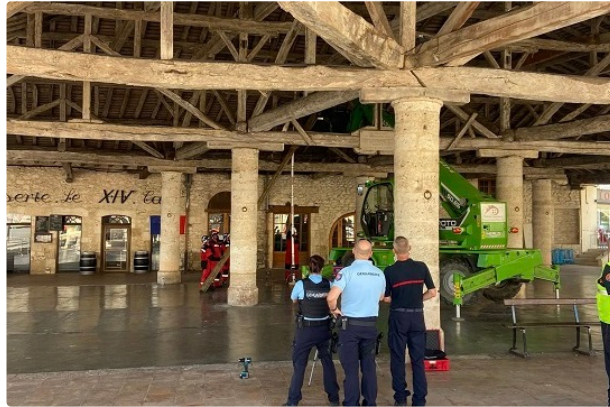
La halle aurait pu s'effondrer
