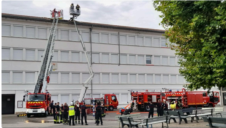
Fleurance, collège Hubert Reeves : feu de panneaux photovoltaïques
