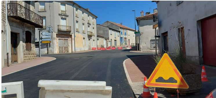
Fin des travaux de l'avenue des Pyrénées avec un changement important au carrefour de la route de Marambat !
