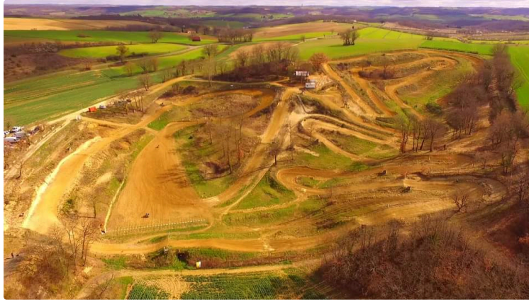
Réfection du chemin d'accès au terrain de motocross
