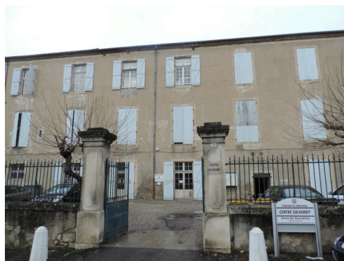
Quel sera le coût de la réhabilitation du centre Salvandy
