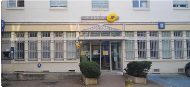
La Poste fermée pour travaux
