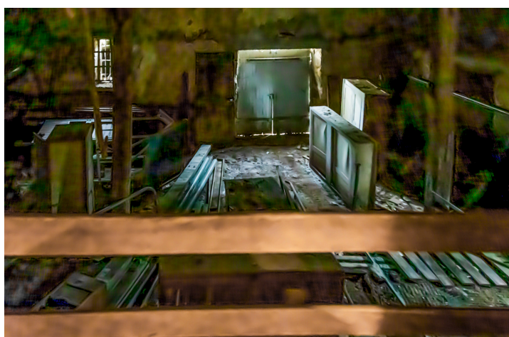
La salle culturelle avant son aménagement
