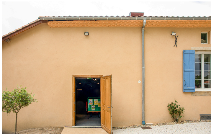
Porte de la salle culturelle, sur la gauche du bâtiment
