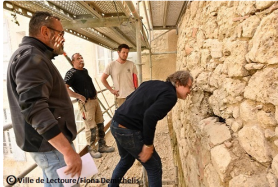
Visite du chantier du rempart de la Tour du Bourreau
