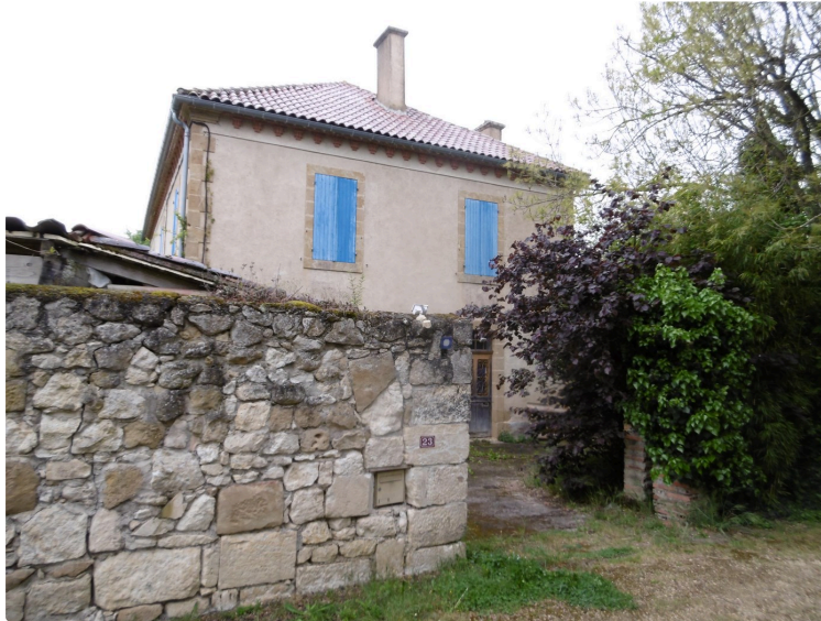
Réhabilitation de l'ancien presbytère soutenue par le programme « Villages d'avenir »
