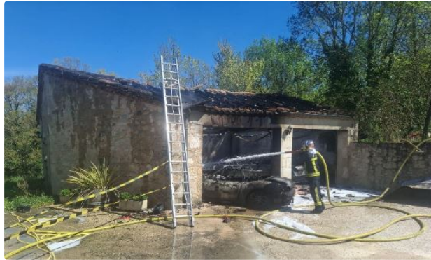
Le garage de 80 m2 contenant deux véhicules totalement détruit par un incendie
