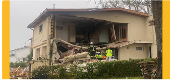
Explosion suivie d'incendie avec 2 victimes
