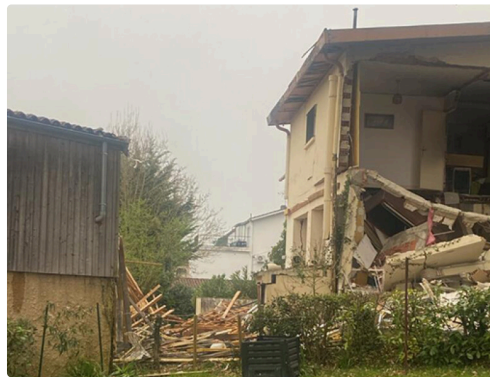
cazaubon explosion 3.jpg
