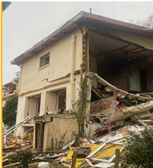
cazaubon explosion 2.jpg
