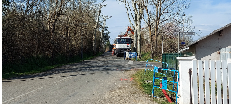
Les travaux d'entrée de ville route d'Eauze sont lancés !
