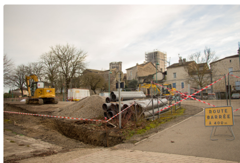
Un village en chantier.
