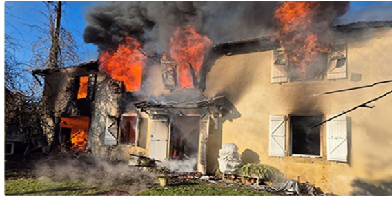
Une maison détruite par un violent incendie
