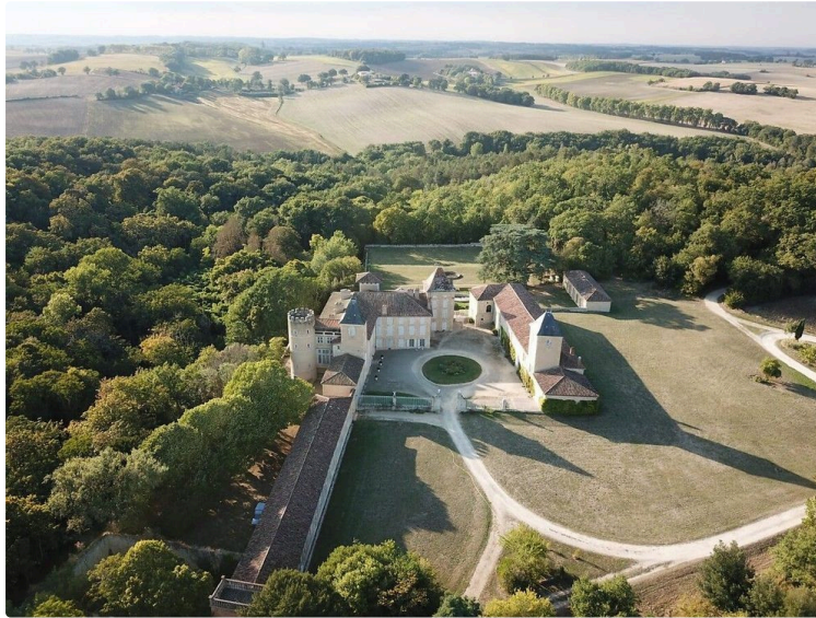
Sauvegarde du patrimoine : les écuries du château de Magnas subventionnées à hauteur de 250 000 euros
