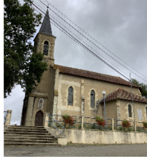
Rénovation de l'église : le chantier va bientôt commencer !
