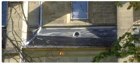
plaisance eglise toit 2.jpg
