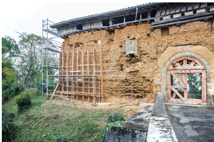
Travaux sur le Castet et son rempart de terre crue en 2017
