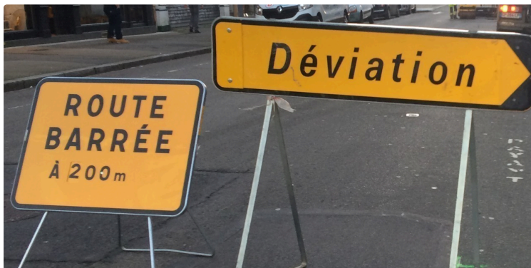
Circulation : mesures de sécurité et fermetures des routes D12, D161, D253 et D924
