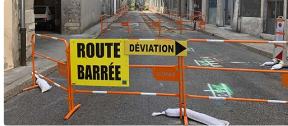
Travaux : Restriction de circulation en ville
