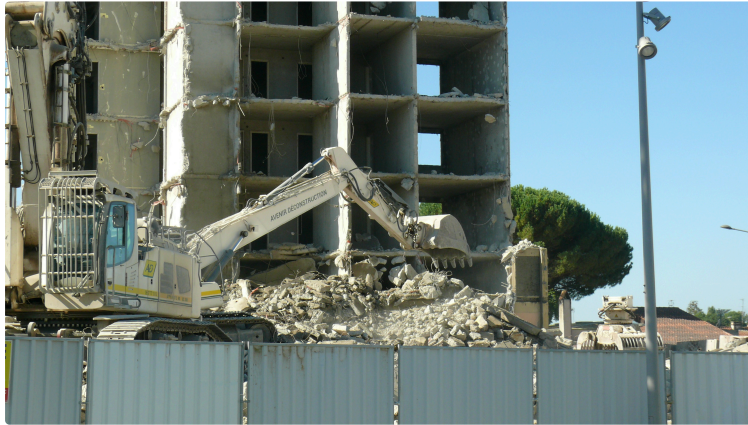
Déconstruction de la tour Athos
