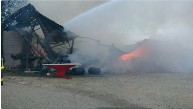
Un hangar de 300 m2 détruit par un incendie
