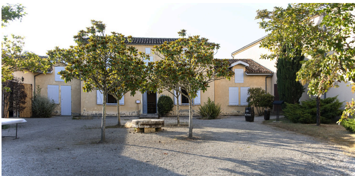
Les mêmes bâtiments aujourd'hui, sur la gauche du chai du Château Saint-Gô
