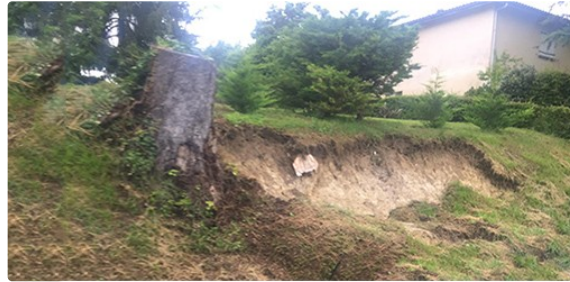
Mise à jour de la situation du réseau routier gersois
