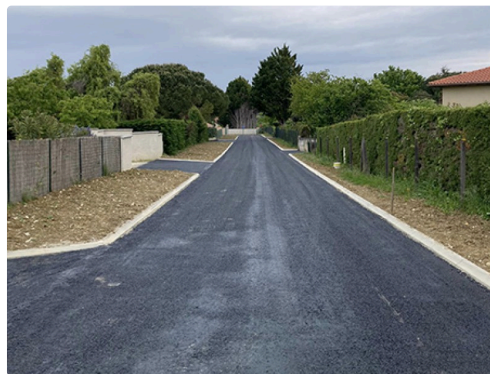
condom travaux 3.jpg
