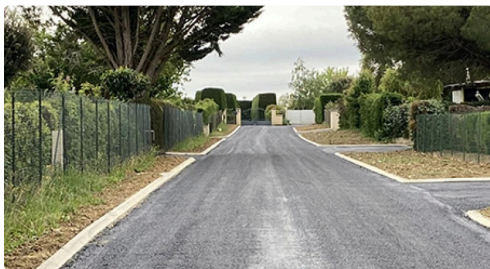
condom travaux 2.jpg
