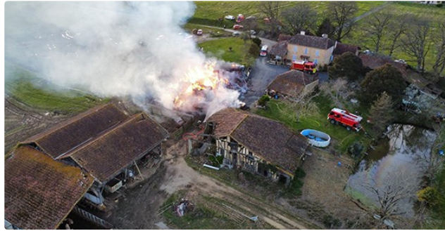
Incendie d'un bâtiment agricole
