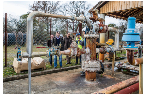
La station vue de l'intérieur
