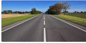
Circulation : D924 fermée à Auch en raison de travaux
