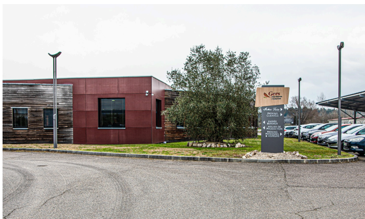
Le bâtiment des bureaux
