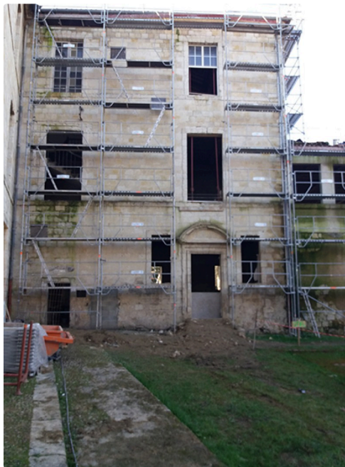
condom salvany travaux.jpg
