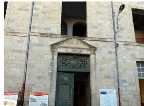
condom salvany travaux 2.jpg
