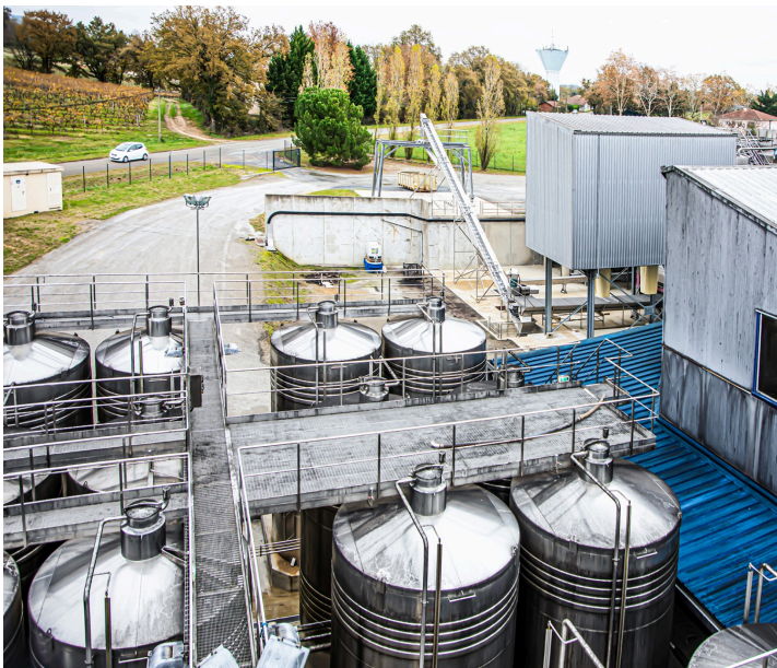
La cuverie moderne installée à partir de 2018
