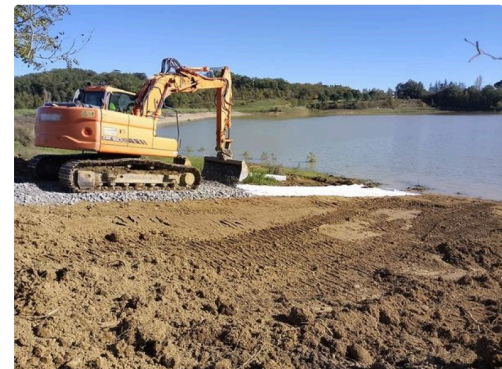
peche travaux en cours.jpg
