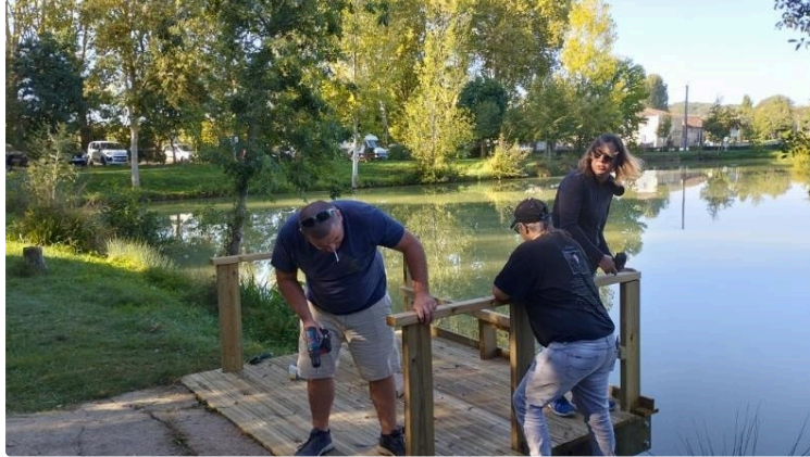
Des travaux pour le confort des pêcheurs
